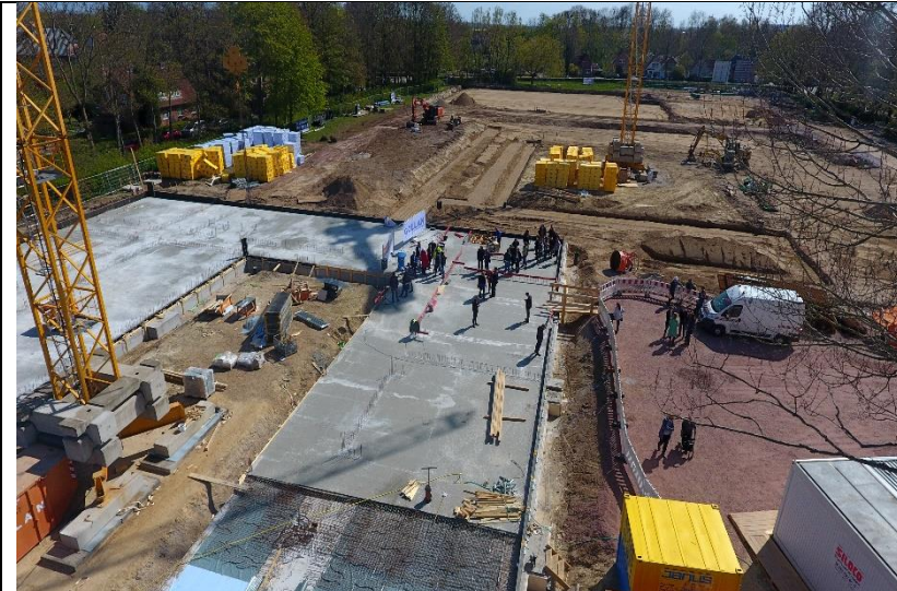
1. Baufeld aus der Vogelperspektive (zum Zeitpunkt der Grundsteinlegung)
